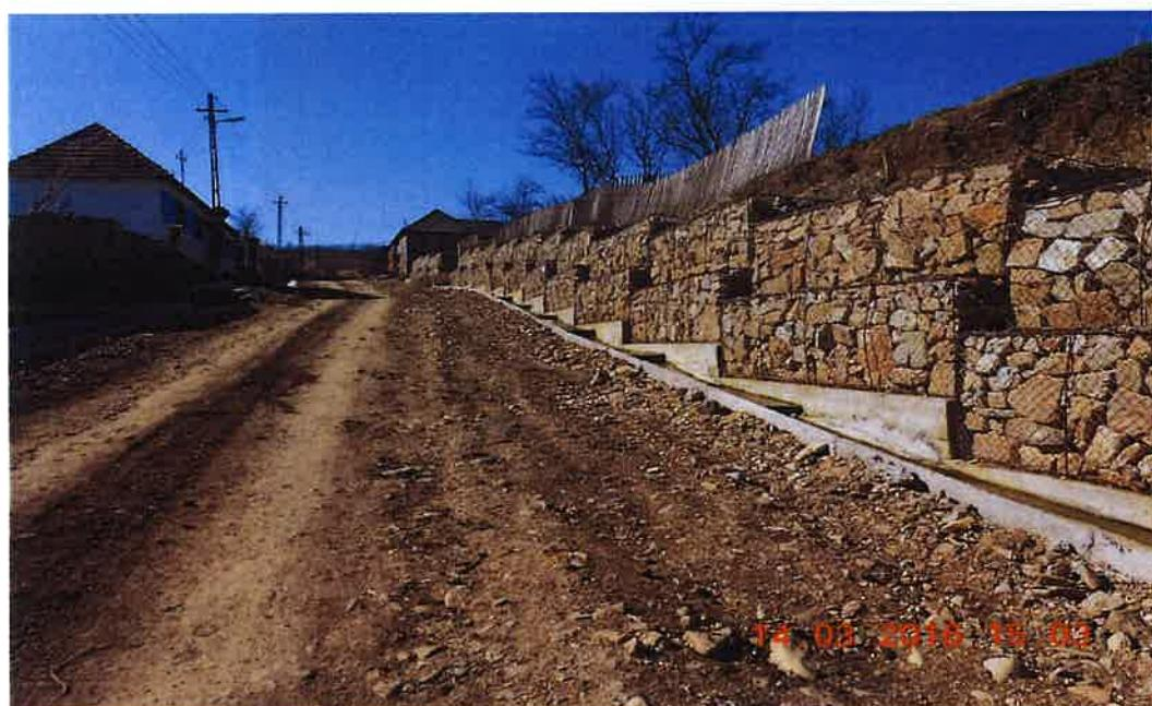
Fig. 20 - Localitatea Poelușa de Beiuș - Zid de sprijin/taluzuri/dispozitive colectare apă pluvial
