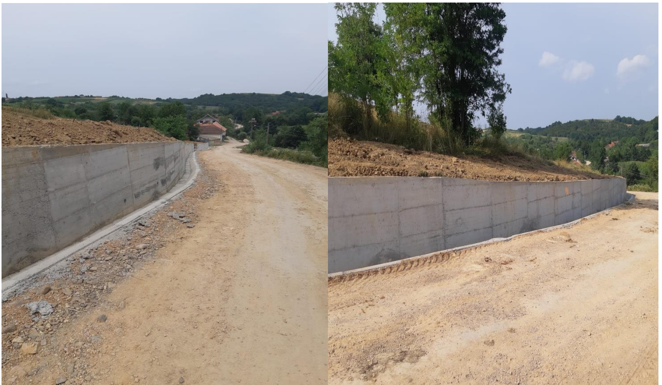
Fig.24 - Consolidare taluzuri, zid de sprijin în localitatea Urviș de Beiuș
