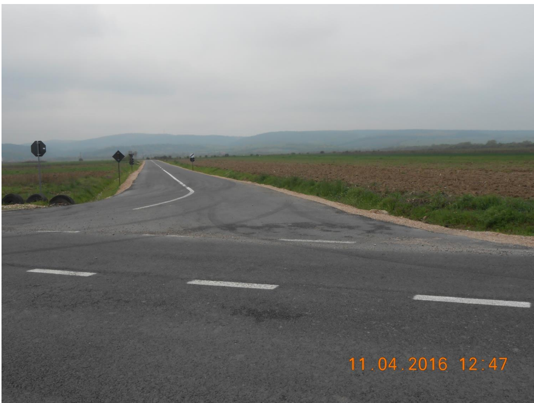
Fig.16-DC 208 Ursad -Poclușa de Beiuș, după modernizare
