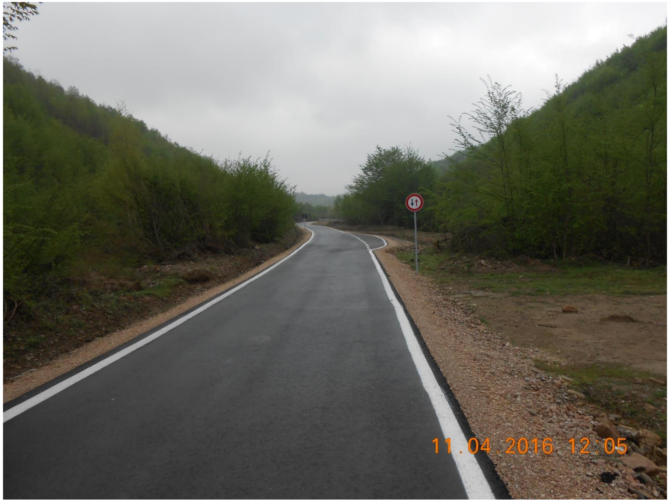
Fig.15- DC 230, Șoimi-Codru , după modernizare
