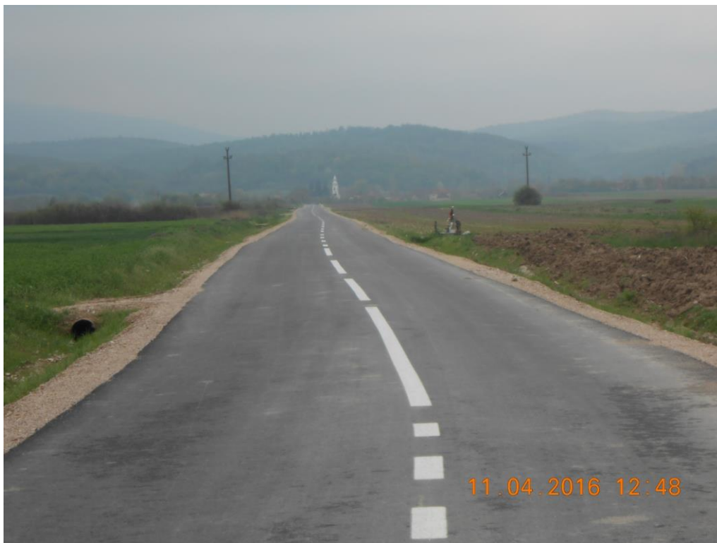
Fig.17- DC 208 Ursad-Poclușa de Beiuș -modernizat
