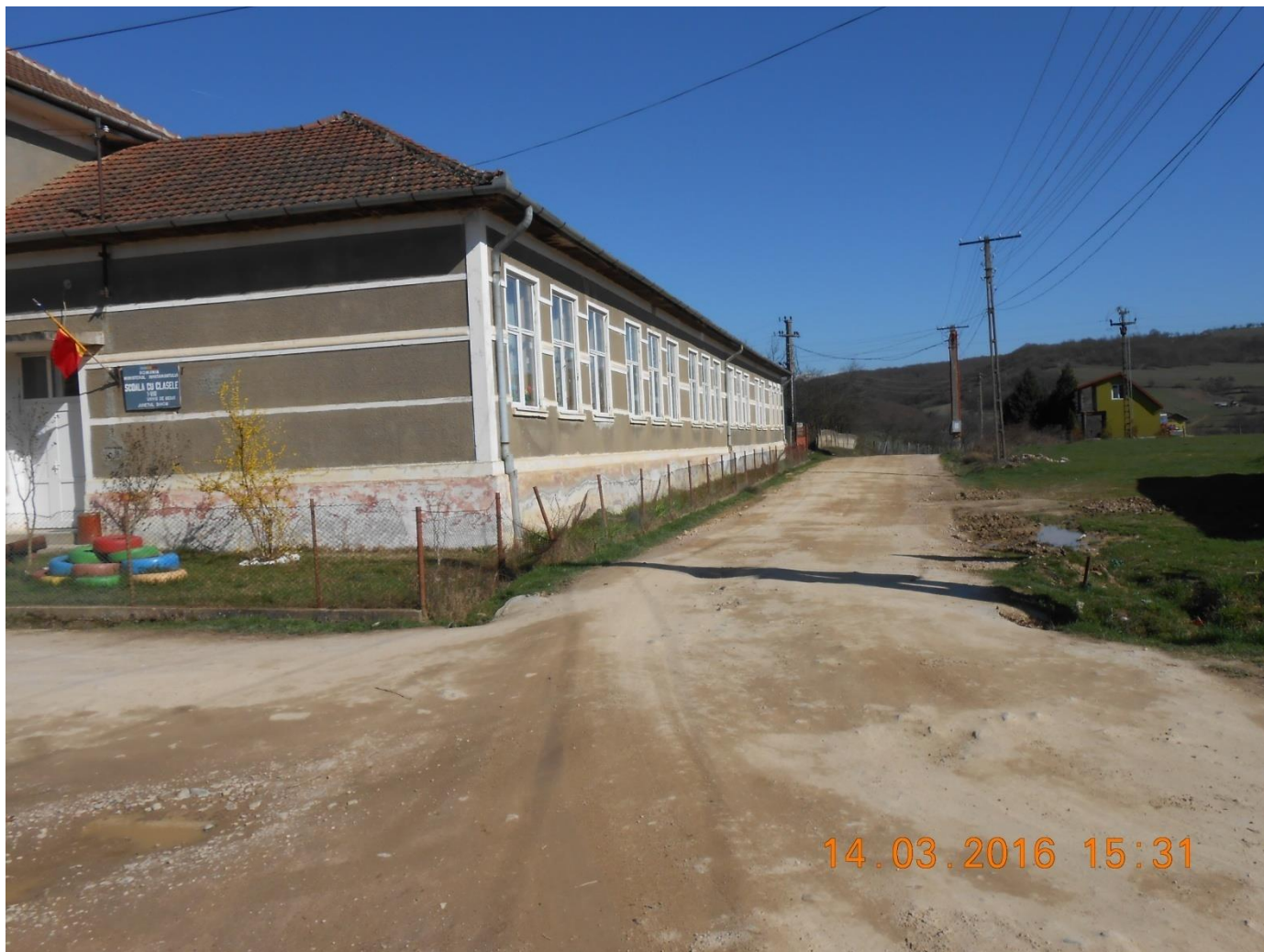
Fig. 10 -Școala Gimnazială Nr. 1-Urviș de Beiuș, înainte de reabilitare
