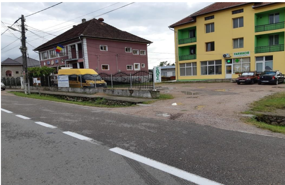
Fig.25 - Amenajare parcare la sediul primăriei Comunei Șoimi-înainte de modernizare
