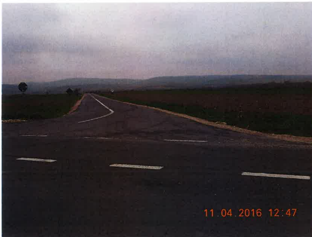
Fig.16-DC 208 Ursad -Pocluşa de Beiuş, după modernizare
