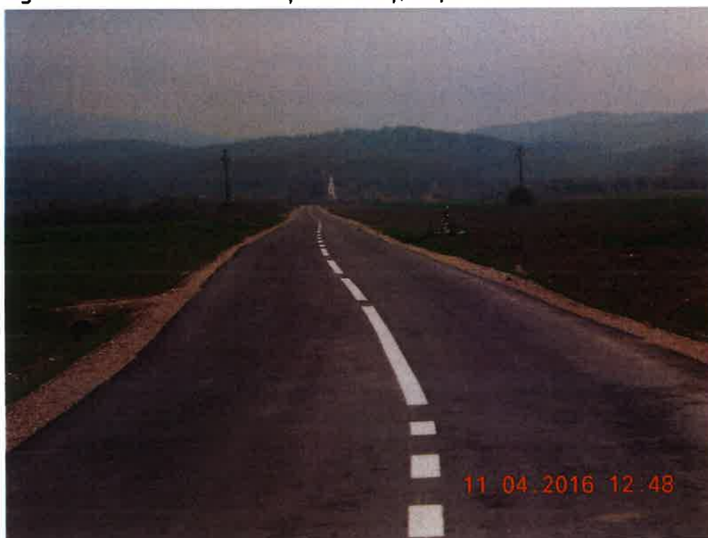
Fig.17- DC 208 Ursad-Pocluşa de Beiuş -modernizat
