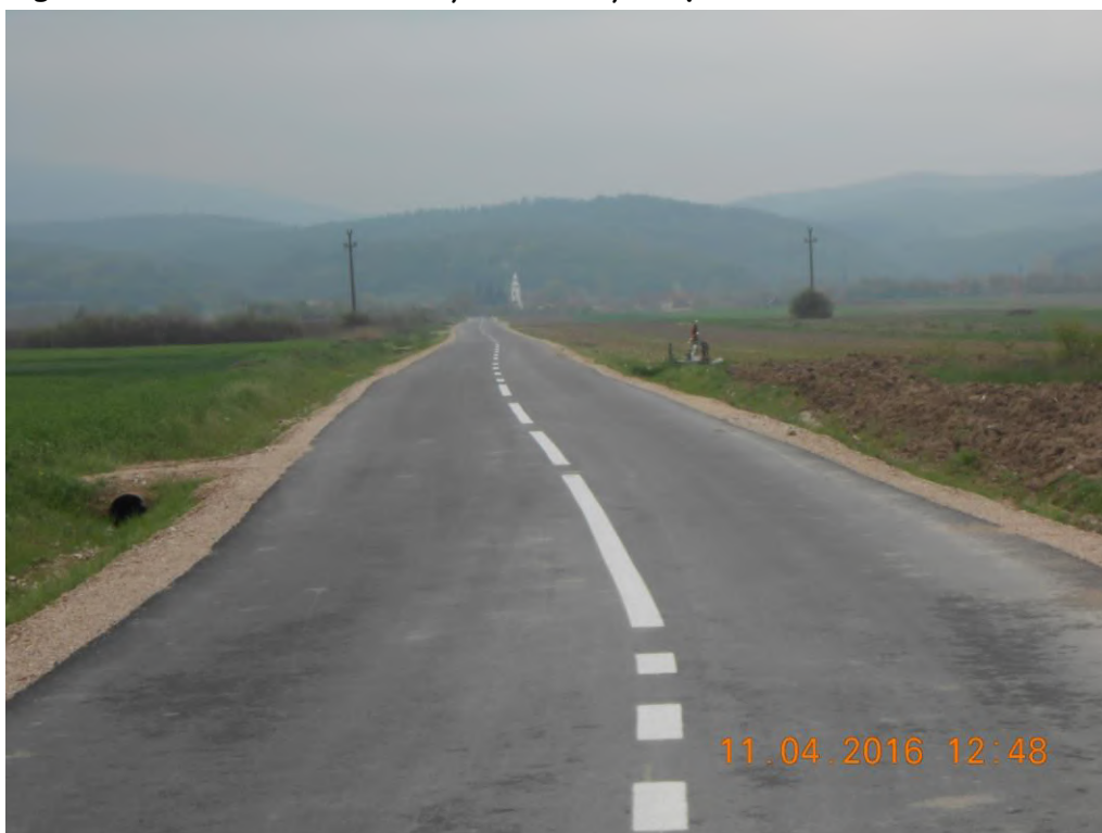
Fig.17- DC 208 Ursad-Poclușa de Beiuș -modernizat
