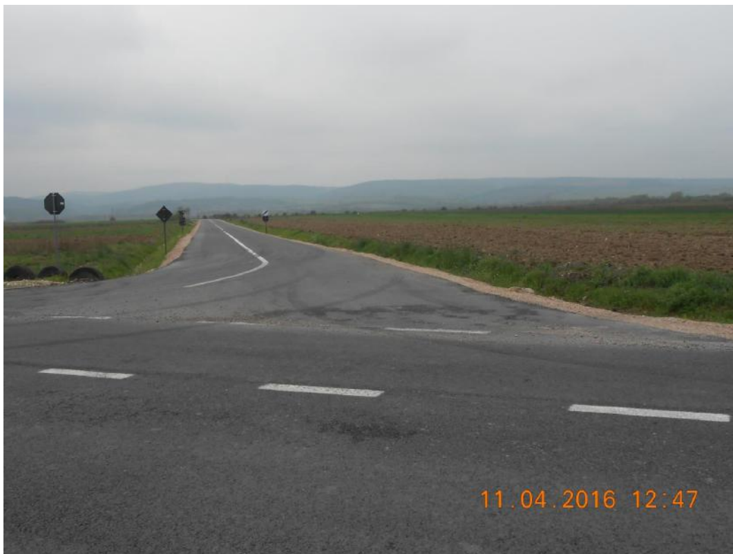
Fig.16-DC 208 Ursad -Poclușa de Beiuș, după modernizare
